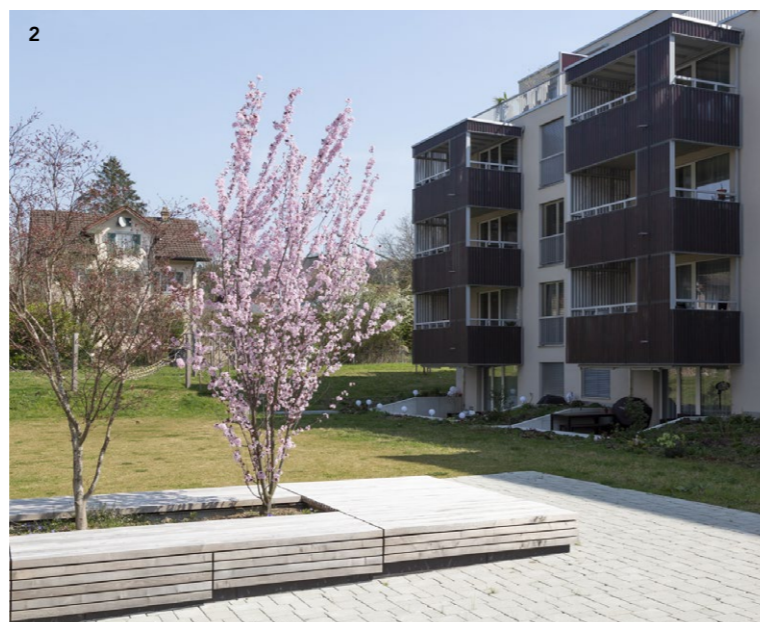
1 + 2 Drei Neubauten und ein bestehender Bau bilden die Überbauung Sentmatt mit insgesamt 141 Wohnungen.
