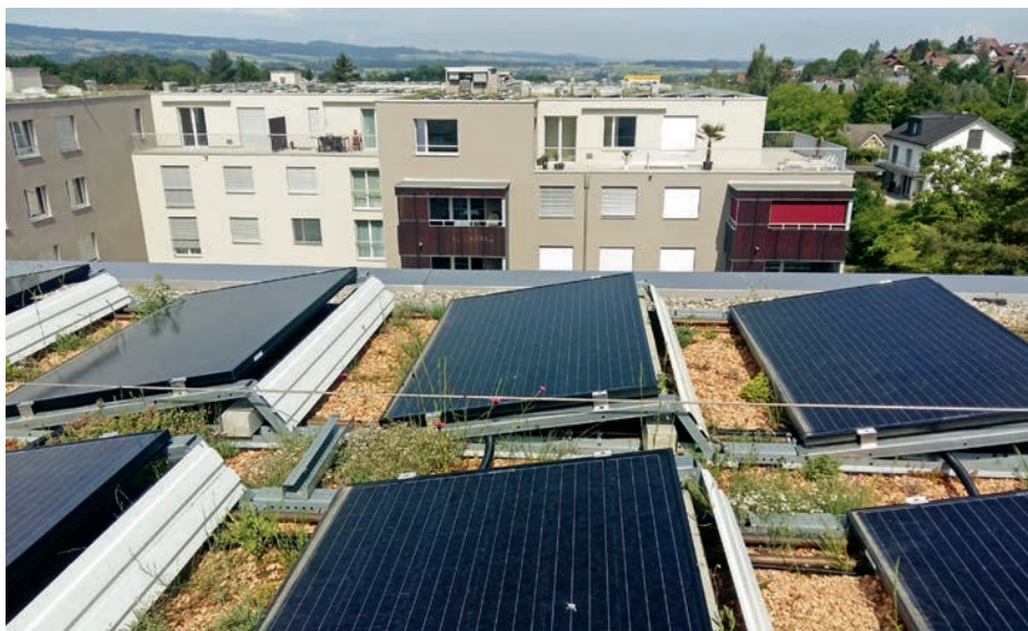
Solare Hybridkollektoren zur Stromerzeugung und Warmwasseraufbereitung.
