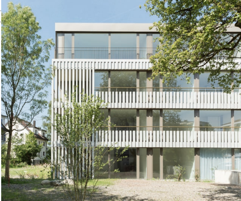
2SOL wird bereits in mehreren Gebäuden eingesetzt, so auch an der Buchzelgstrasse in Zürich-Witikon. Bewährte Technologien und Komponenten wurden durch die Allianz als Gesamtsystem optimal aufeinander abgestimmt.
